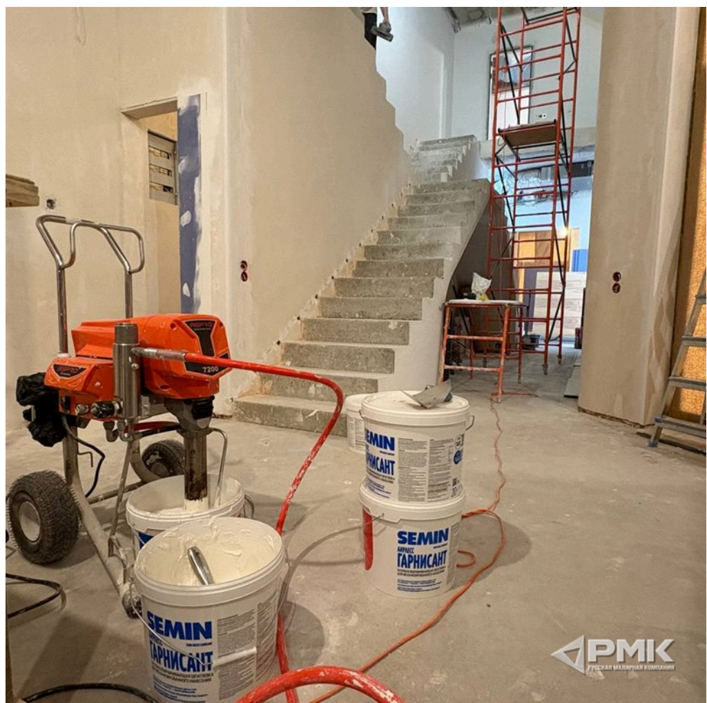
Механизированное нанесение на объекте. Шпатлёвки Semin, безвоздушный аппарат.
